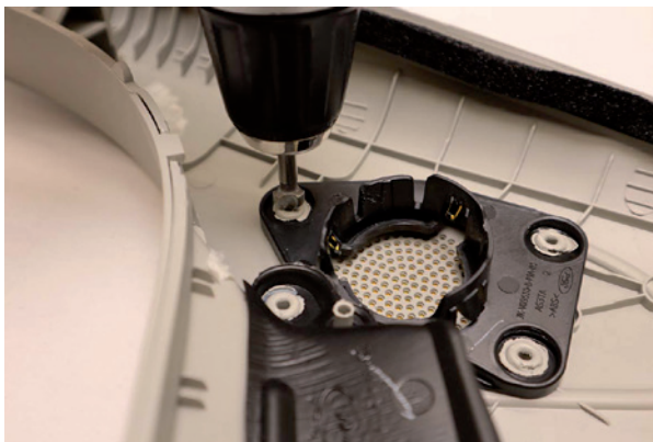
4.4. Werkseitiges Hochtton-Modul auf der A-Säulenrückseite entfernen (3x Kunststoffnieten aufbohren).
